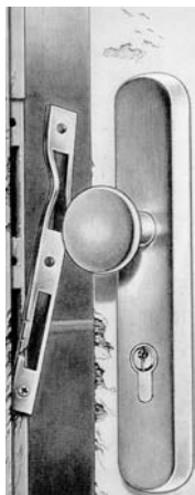
Bild 3.21: Ausgerissenes Schließblech
