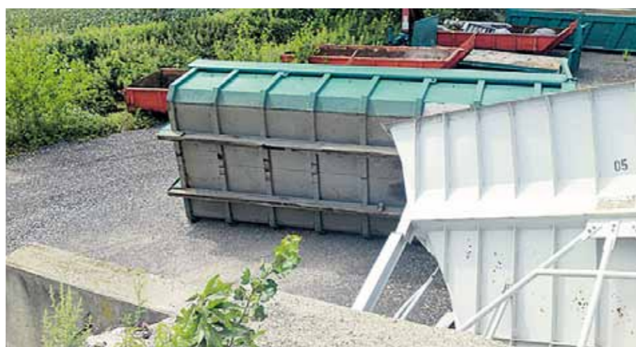
Die grüne Wanne brachte die gesamte Mischanlage zum Einsturz.
